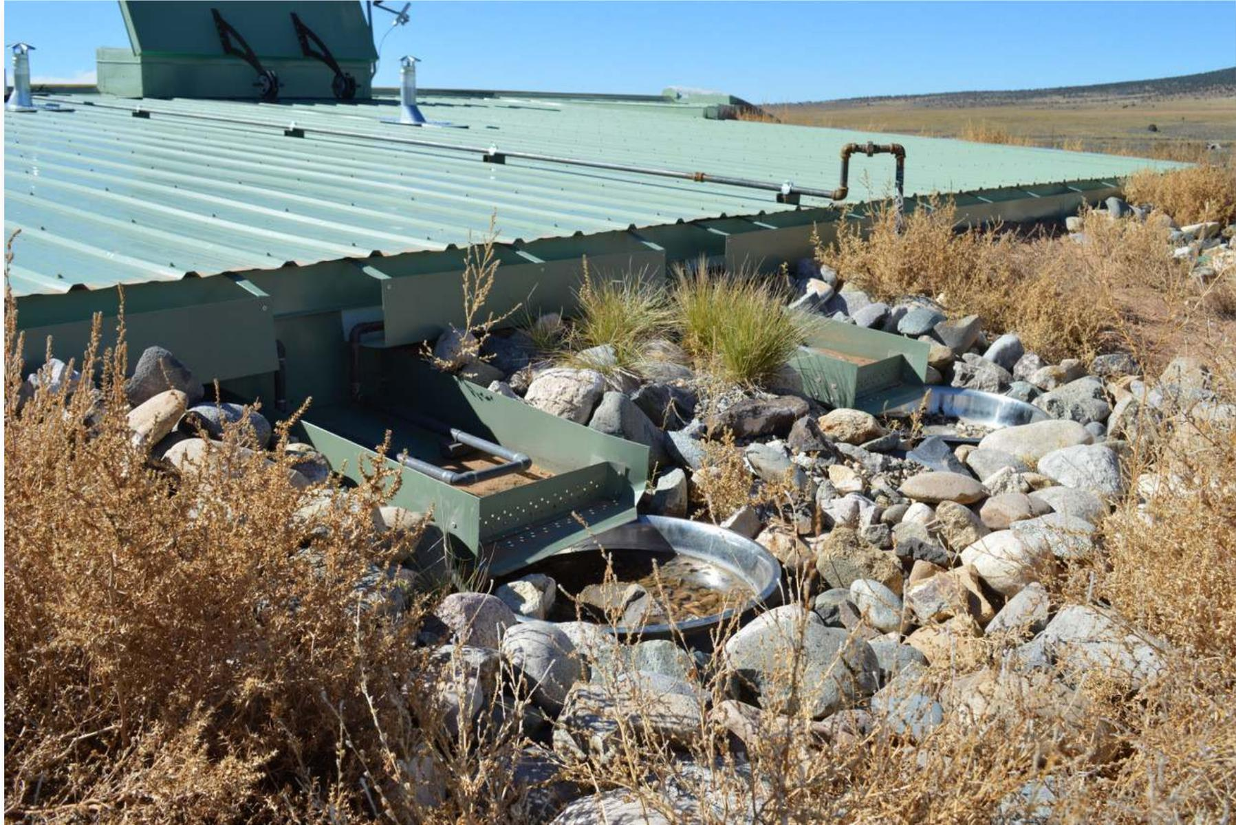
On voit ici le système de récupération de pluie en bordure de toit et de préfiltration en amont des citernes enterrées. On observe également un tube dans les gouttières : l'hiver, un fluide caloporteur fait fondre la neige et la glace, principale source d'eau dans les régions désertiques très froides l'hiver (Cet Earthship se situe dans le désert du Nouveau Mexique).
