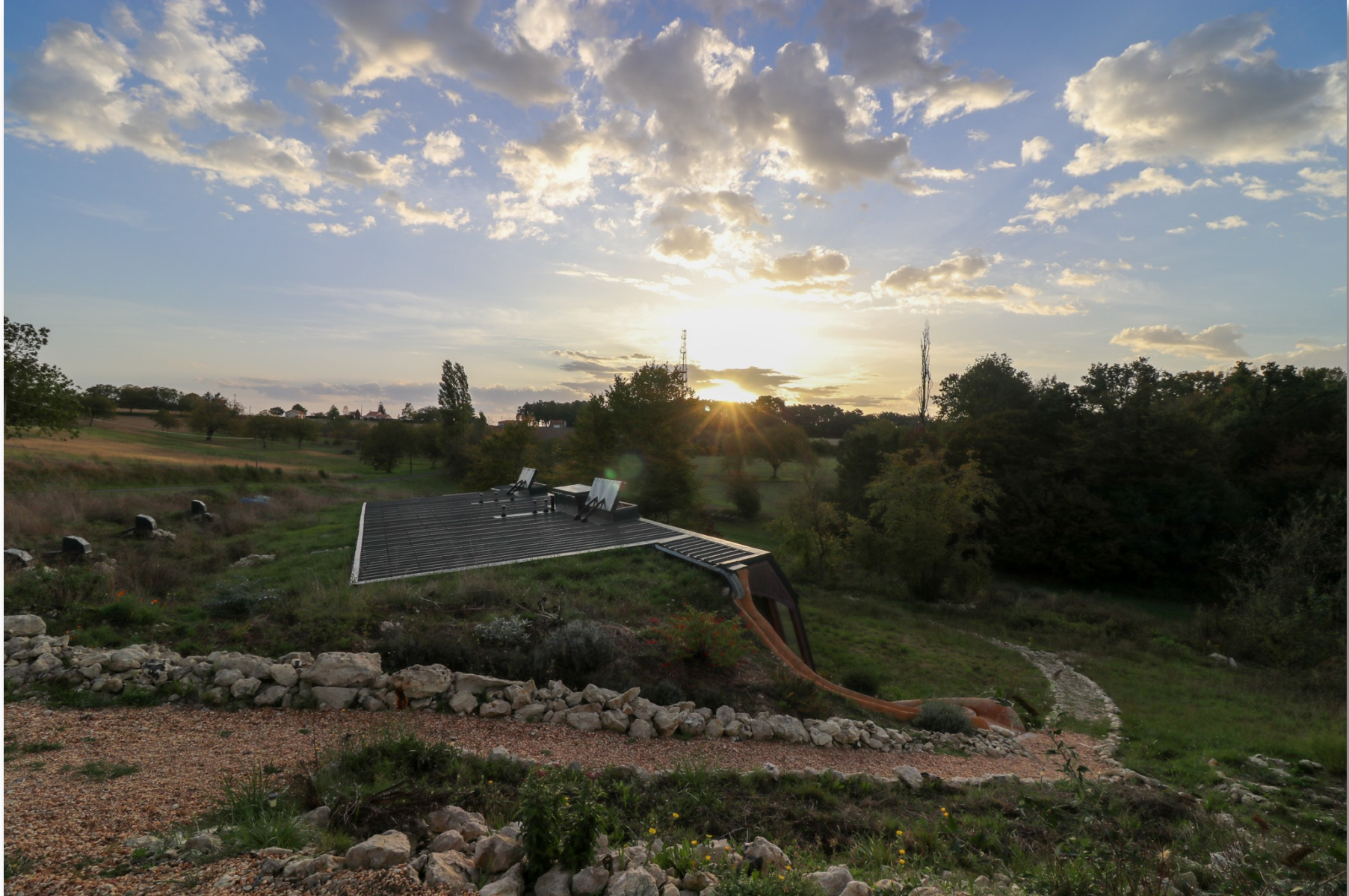
Vue du toit
