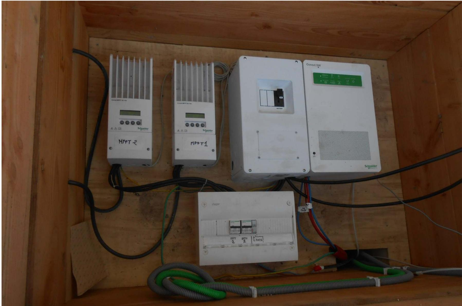
On observe sur cette photo le module de traitement de l'électricité. Il s'agit d'un ensemble de composants d'électronique de puissance (onduleur, contrôleur de charge, disconnecteur, etc..).
