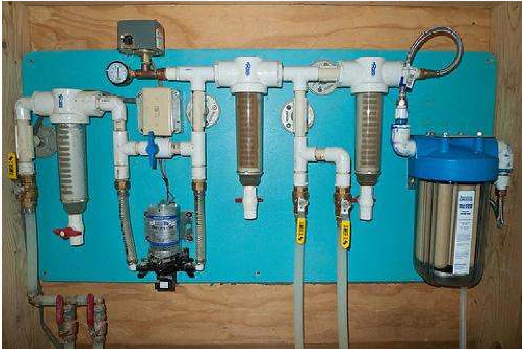
Il s'agit là du module de traitement de l'eau. L'eau des citernes passe par une succession de filtres et une pompe afin d'être consommable et pressurisée.
