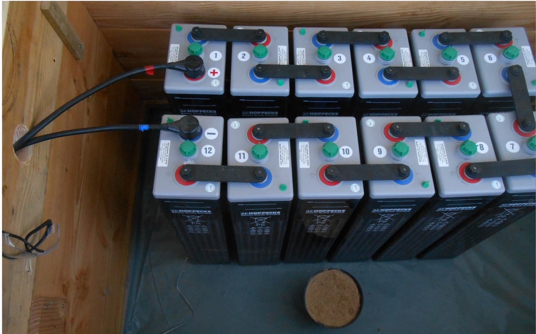
Batteries au Plomb. C'est une technologie éprouvée, abordable et recyclable à 98%. Pour l'habitat, nous les préférons aux batteries lithium.
