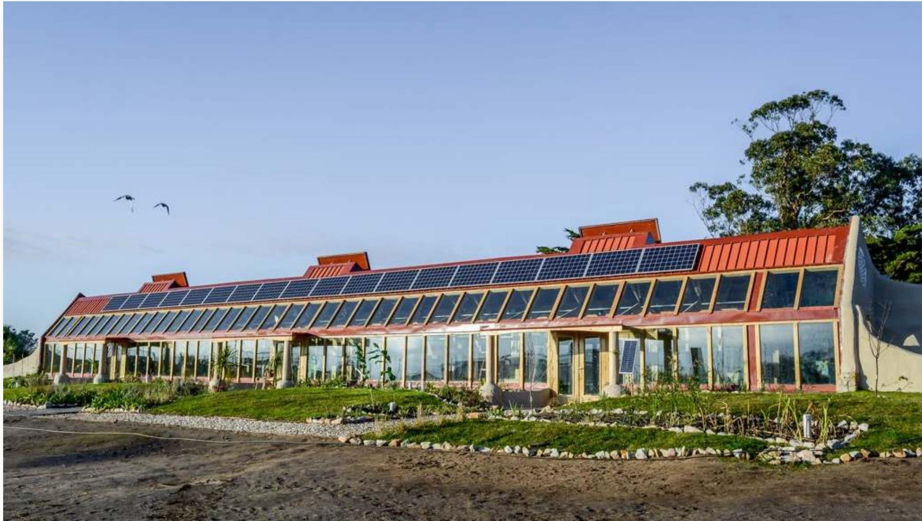
Les Earthships sont aujourd'hui des modèles éprouvés pour habiter de manière autonome et écologique. Ils répondent à six besoins humains fondamentaux : un logement confortable thermiquement, des énergies renouvelables (solaire / éolien), le traitement local des eaux usées, l'utilisation de matériaux recyclés, la récupération de l'eau et la production alimentaire. Ces maisons autonomes ont déjà été construites sous différents climats tout autour du globe et y ont fait leurs preuves.
